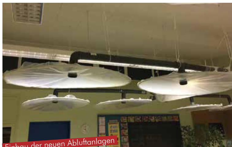
Einbau der neuen Abluftanlagen
