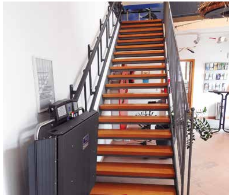
Barrierefreier Zugang Obergeschoß
